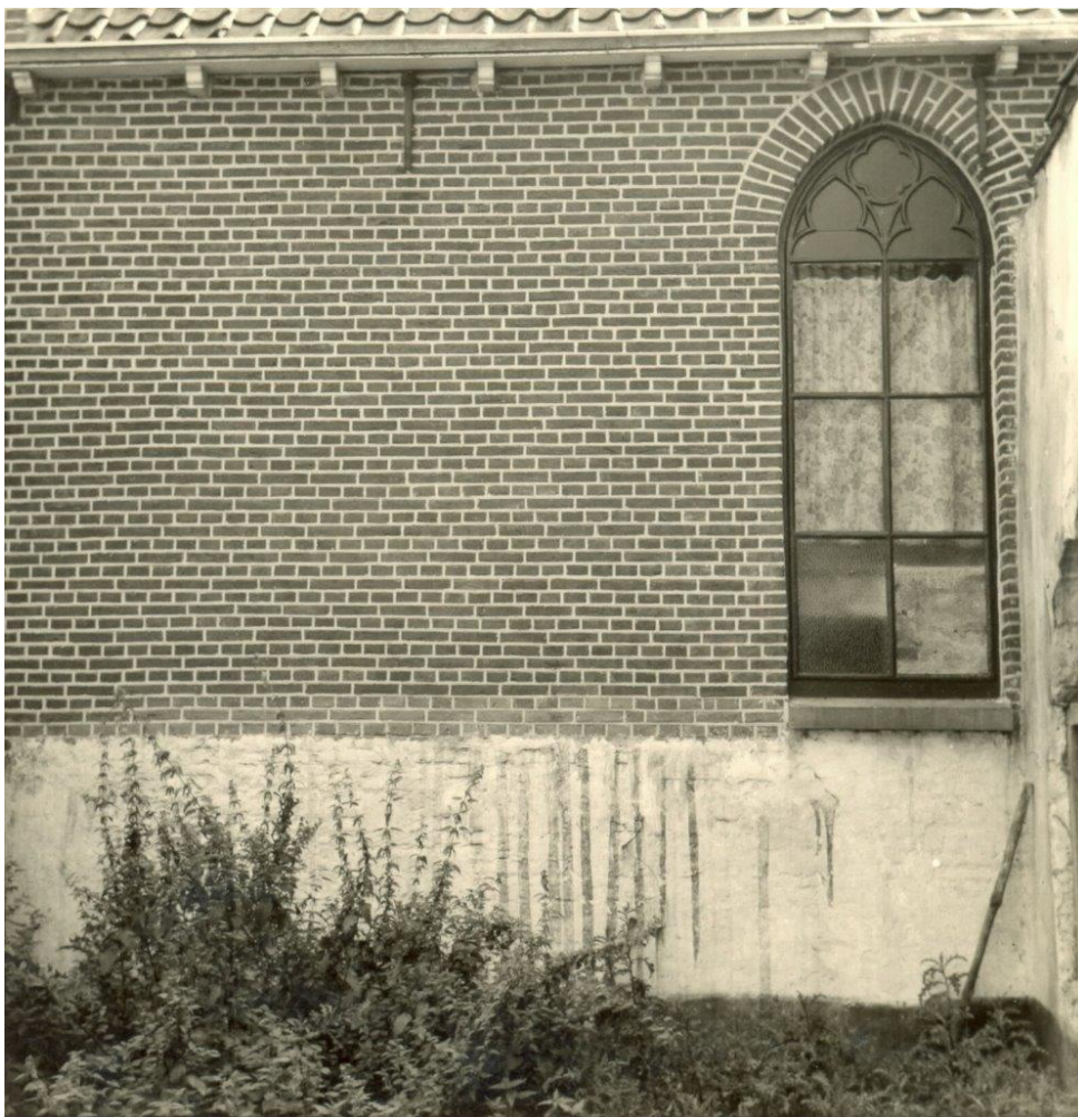
(8) De vrije westmuur van de voormalige synagoge in 1959. De witgekalkte hobbelige onderzijde verbergt het muurwerk van zijn voorganger. Hier tegenaan lag de mestplaat van de naastgelegen boerderij. In het onderste vak van het zijvenster is na 1947 aangebrachte verdiepingvloer nog duidelijk te zien. (Foto collectie A.J. van der Worp)
