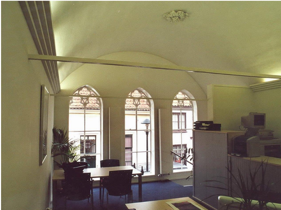
(14) Een kijkje in de herbestemde synagoge in 2004 op de verdieping. De trekstangen van oost naar west lopend, zijn hier goed zichtbaar. Aan het plafond twee rozetten waar lichtkronen aan hebben gehangen. (Foto G.J. Wever)
