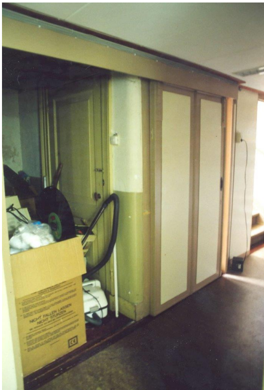
(11) Het ingangsportaal van binnenuit afgebeeld, situatie 2002. De binnendeur links is de nog oorspronkelijke toegang van de gebedsruimte. Op de kopse zijde van het portaal is rond 1948 in het verlengde van de buitendeur een grotere doorgang gemaakt, die met de schuifdeur kon worden afgesloten. Tijdens de openingstijden van de winkel werd de deur naar links geschoven voor het portaal langs, die zoals op de foto ook te zien wel als werkkast zal hebben gediend. (Foto G.J. Wever)
